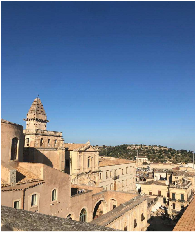
Fig. 4. Noto (SR). Vista sul Monastero del SS. Salvatore.
